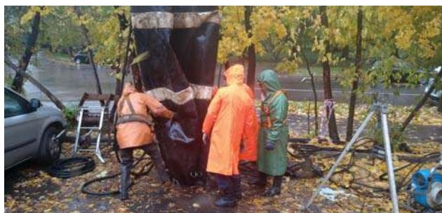
Установка перекрытия 2200 мм в коллектор через люк 600 мм
