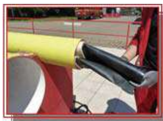
Помещение в канал
